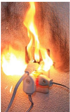
トラッキング現象
