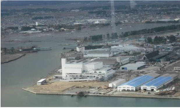
② 石巻市重吉町 石巻広域クリーンセンター
