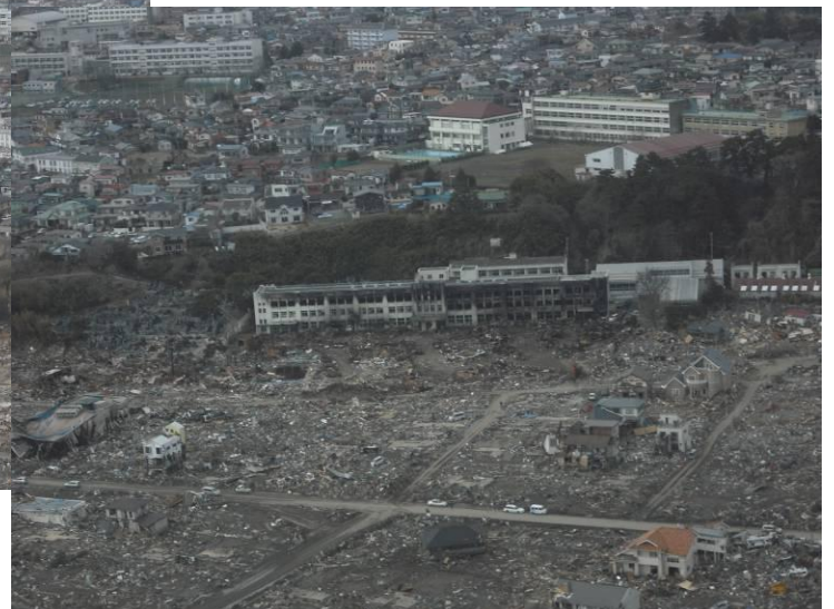
⑥ 石巻市南浜町門脇町(林の上は日和山の宅地) 右側の焼けた建物は、津波襲来後火災に遭った門脇小学校 その上は市立石巻女子高校
