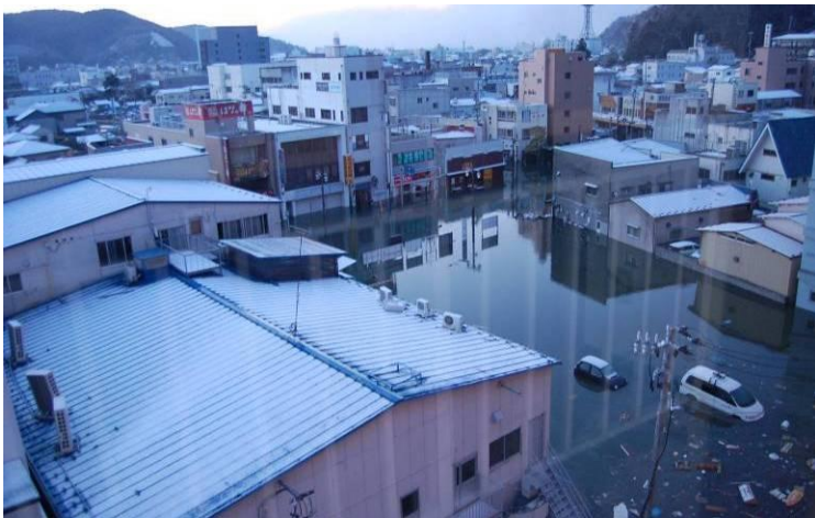
水没した石巻市役所 H23/3/12(土)05:47
