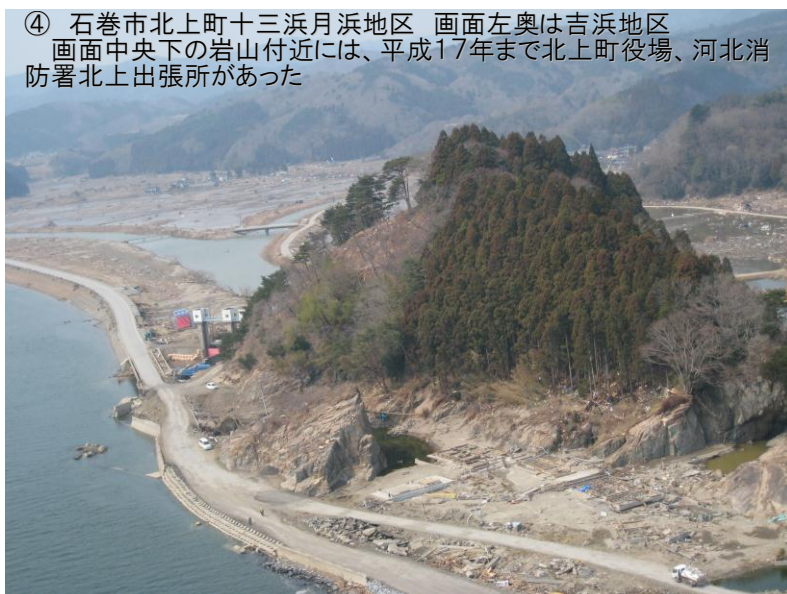
⑤ 石巻市北上町十三浜追波・小田地区(北上中学校前) 左手前の水門を超える高さで津波が遡上
