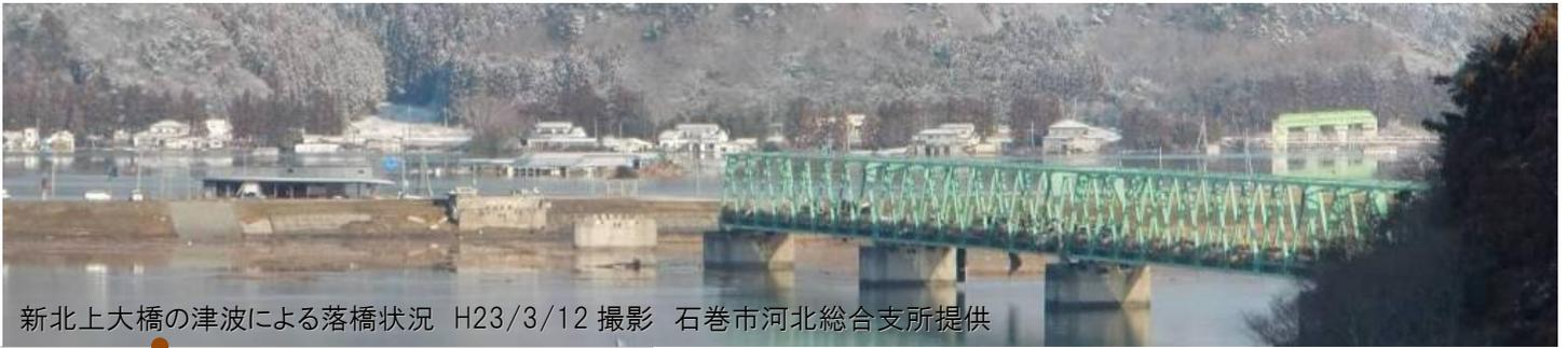
新北上大橋の津波による落橋状況 H23/3/12 撮影 石巻市河北総合支所提供
