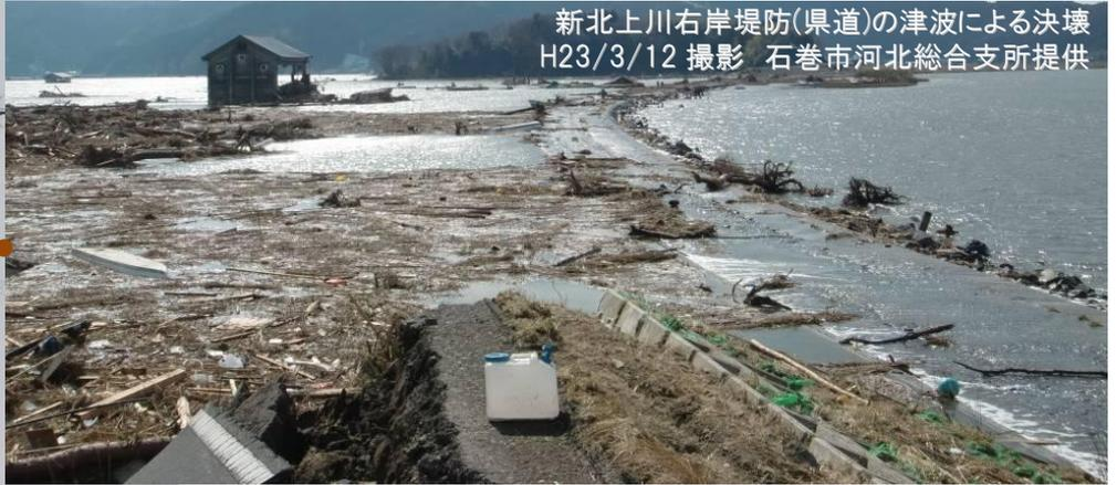
新北上川右岸堤防(県道)の津波による決壊 H23/3/12 撮影 石巻市河北総合支所提供
