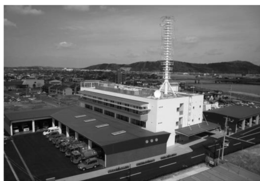
消防本部・石巻消防署
