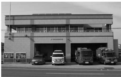
石巻消防署南分署
