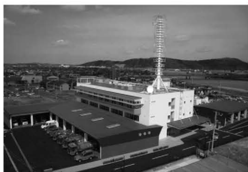
消防本部・石巻消防署
