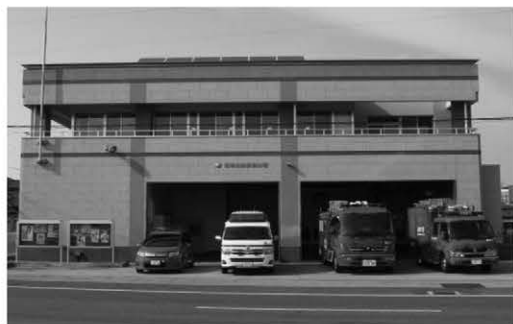
石巻消防署南分署
