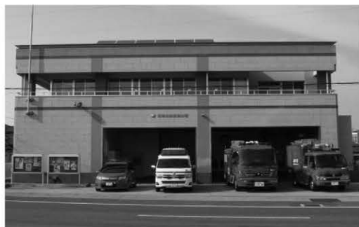
石巻消防署南分署
