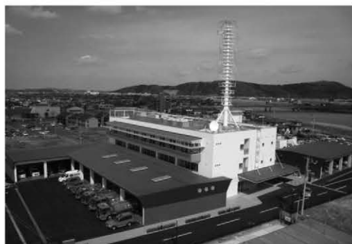
消防本部・石巻消防署 宮城県東部消防指令センター
