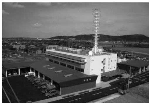
消防本部・石巻消防署
