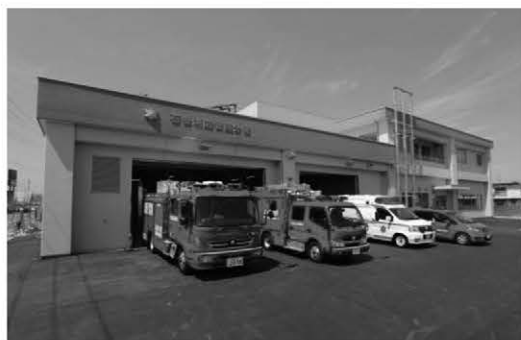
石巻消防署西分署
