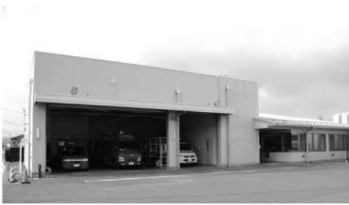
石巻消防署河南出張所
