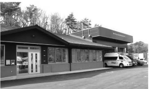
東松島消防署鳴瀬出張所
