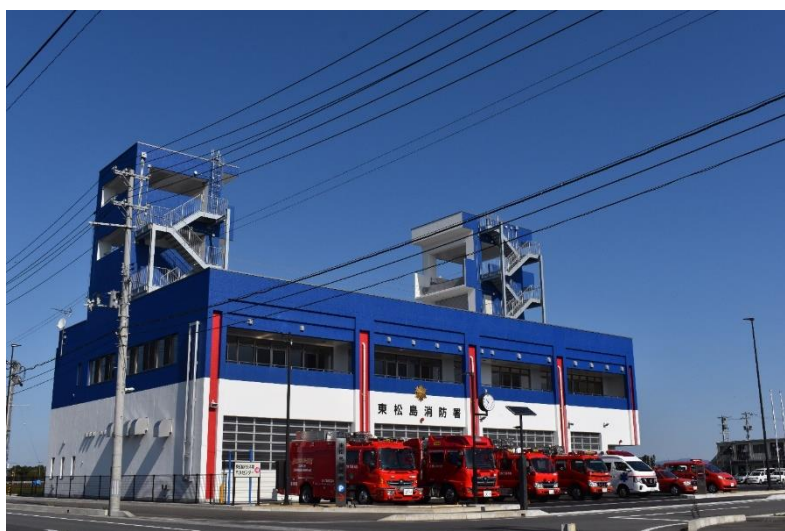
東松島消防署 令和2年11月20日新庁舎運用開始
